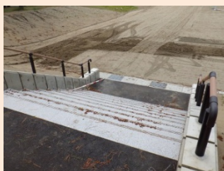
芝生広場競技場入口 階段設置
