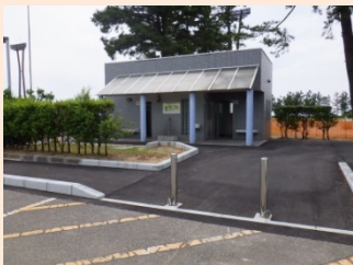
駐車場トイレ周辺 身障者対応
