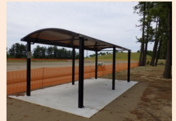
芝生広場東松林 休憩施設
